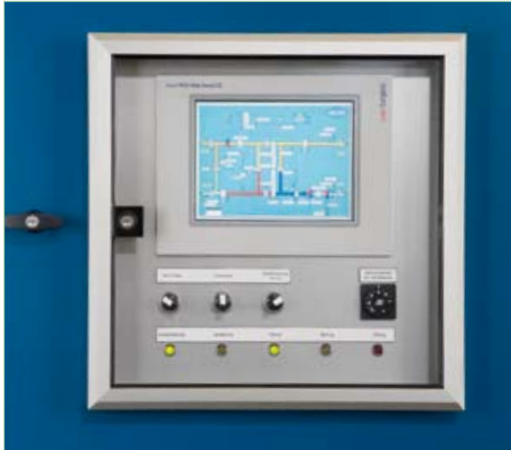
Windows®CE 10" Web-Panel: Die Visualisierung ist in den Web-Servern der Steuerungen hinterlegt.
