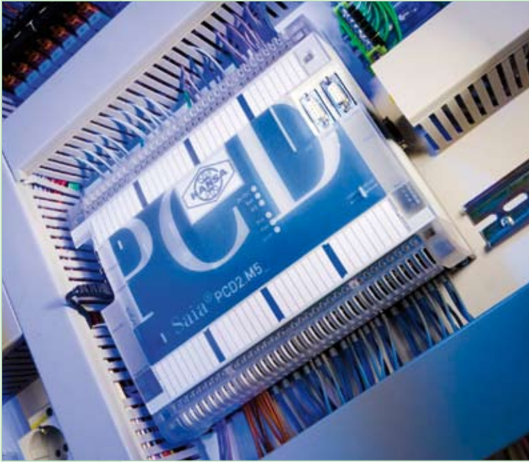
Die neue Saia®PCD2.M5540 im Zentralklimagerät: Genug Power für Applikation, Web-Technik, BACnet®, Feldbus-Schnittstellen.
