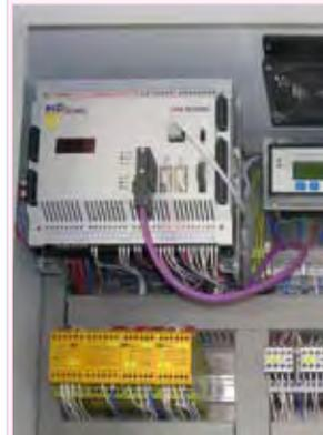
Saia®PCD2.M480 steuert alle Prozesse der Reinraummaschine
