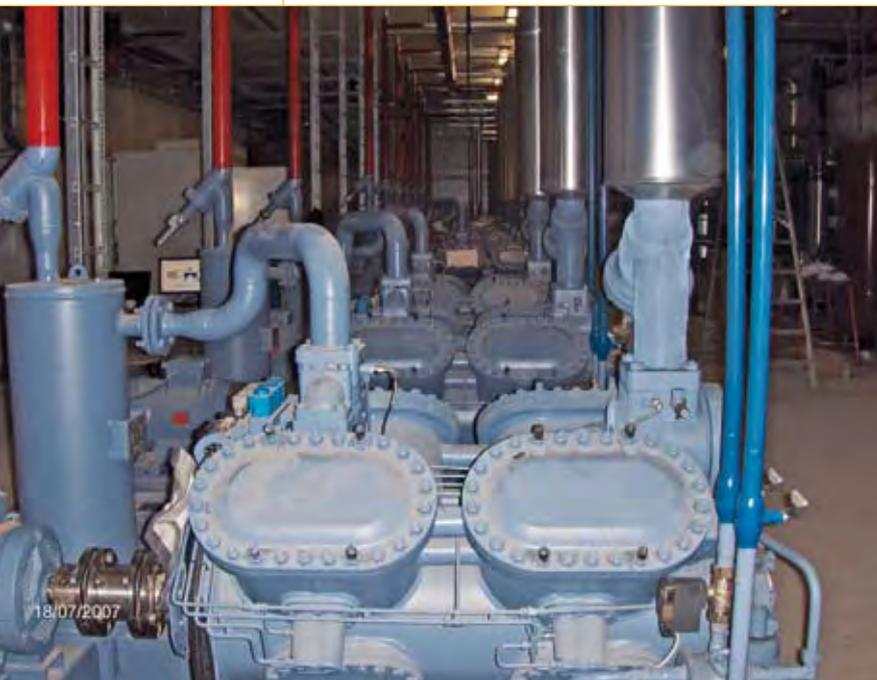
Im kürzlich in Betrieb genommenen ASKO Vest Projekt nahe Bergen, mit 35000 m<sup>2</sup> Fläche, stehen zwei Saia®PCD3 Steuerungen mit 200 analogen Ein- und Ausgängen im Einsatz, welche Temperaturen und Druck von 11 Grasso Kompressoren und mehr als 60 Verdampfapparaten messen.
