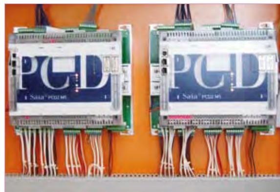
Schaltschrank vor und nach dem Umbau: links der bisherige Staefa Regler, rechts der Saia-Burgess Controls Umrüstsatz mit PCD2.M5540
