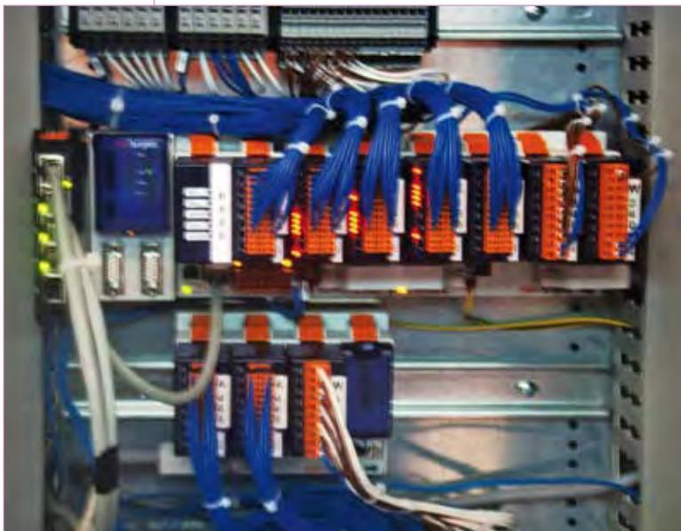
Schaltschrank von Pumpstation mit Saia®PCD3 Steuerungen
