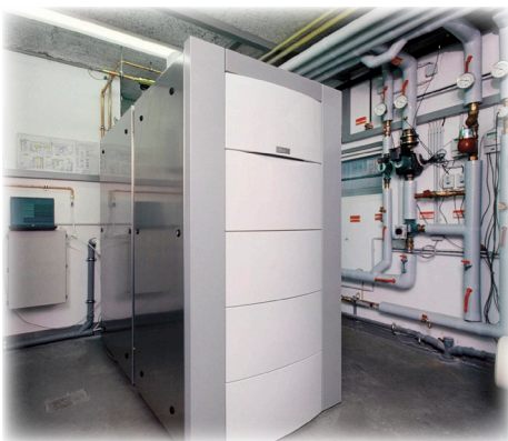
Photo: Vaillant GmbH Chauffage avec pile à combustible lors d'un test de terrain réel
