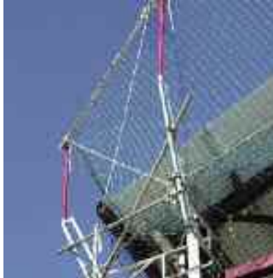
2 Montaje externo de esquina que permite la existencia de voladizos.
