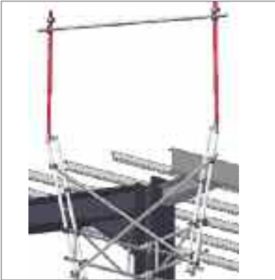
1 Montaje externo de esquina con balaustre y barandilla superior
