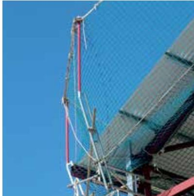
2 Außenecke mit tief montierten Diagonalen, um einen Dachüberstand zu ermöglichen.
