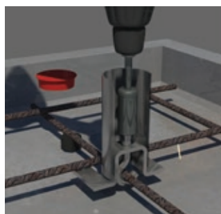
Image 1 : Fixé dans les deux plans pour garantir une verticalité parfaite.
